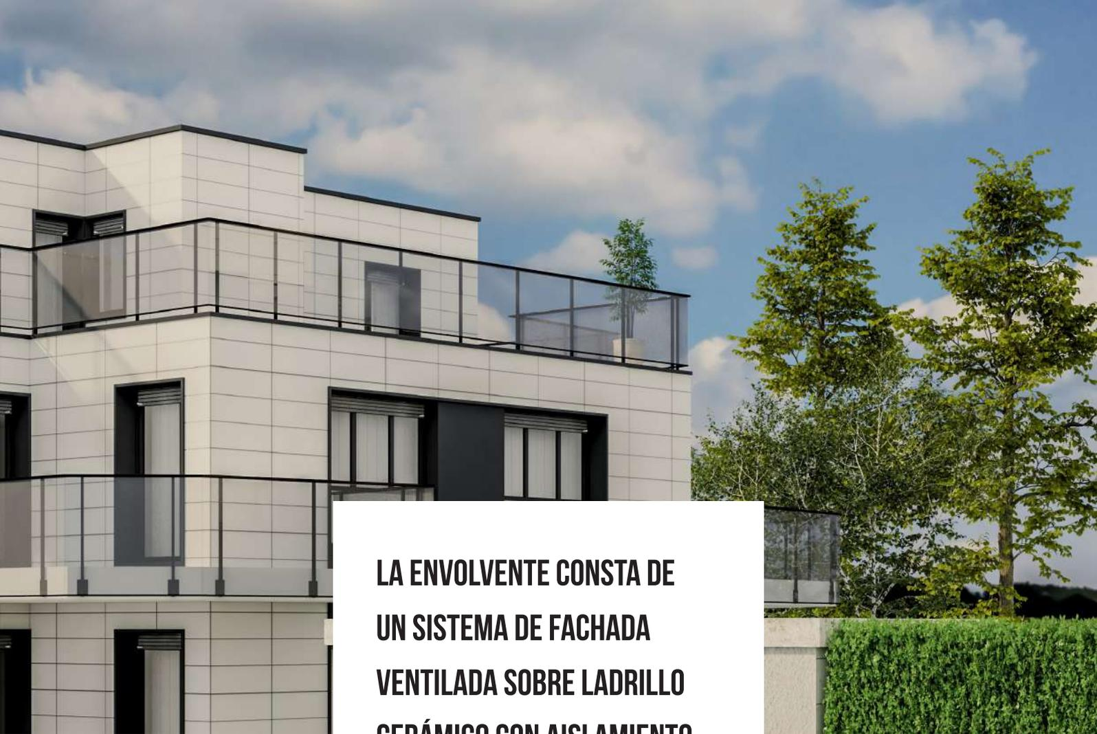
**LA ENVOLVENTE CONSTA DE UN SISTEMA DE FACHADA VENTILADA SOBRE LADRILLO CERÁMICO CON AISLAMIENTO CONTINUO EN EL EXTERIOR DEL CERRAMIENTO.**
